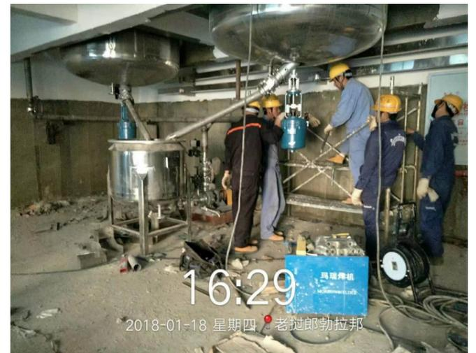
经过设备设施吊运、搬运进厂房等系列前期现场准备工作，现老挝寮云公司新建20000吨乳化生产线101制药工房除少数设备（溶蜡槽、循环水设备）未到位以外，其余设备均已安装到位。
